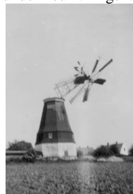
Over Barrit Mølle, 1953 – under nedrivningen.
